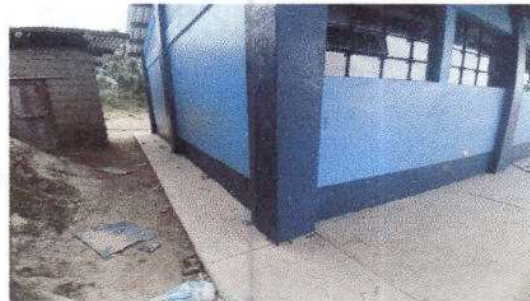
Foto 4: Pintura en muro exterior
