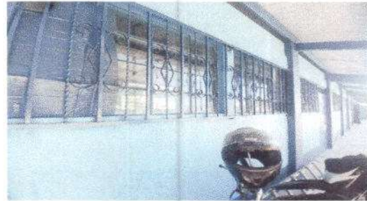
Foto 2: instalacion y colocación de balcones aula 1, 2 ,3 y 4
