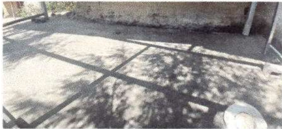
Foto1: Sustitución de piso de tierra por torta de concreto
