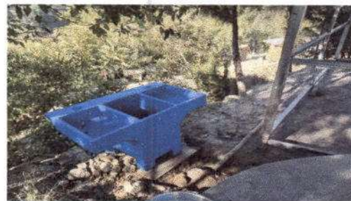
Foto 6: Sustitucion de pila de 2 lavaderos
