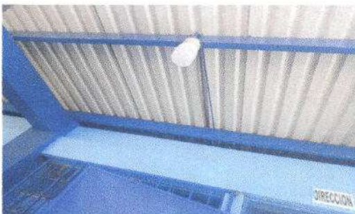
Foto 5: Sustitucion de focos LED
