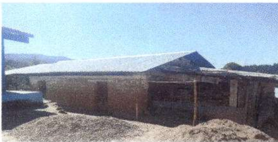
Foto 3: Sustitución de lamina por lamina trquelada
